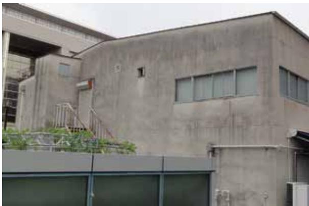
外壁面汚れの様子(流れ落ちる形・ひび割れ周辺)
